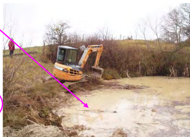
Curage mécanique depuis le bord
