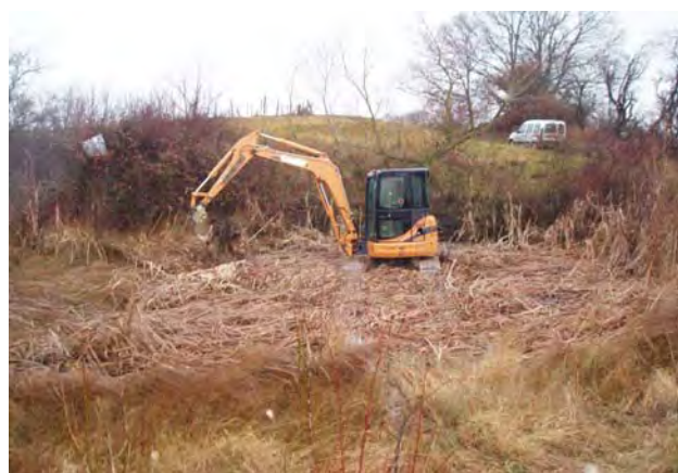
Curage au cœur de la mare, extraction massettes
