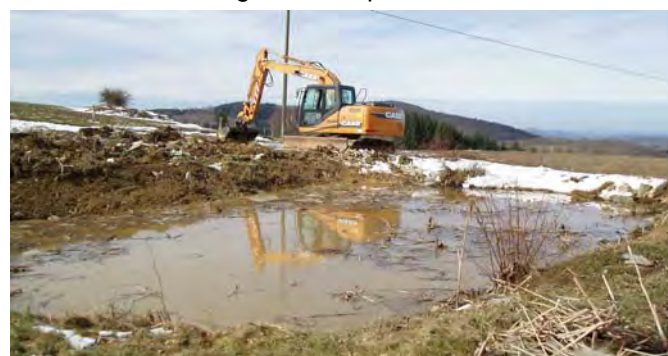
Février 2010 : curage mécanique vase et massettes
