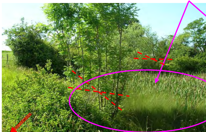
Sud Avant travaux
