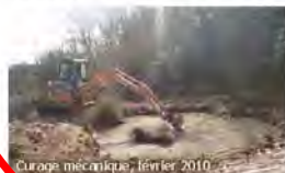
Curage mécanique, février 2010
