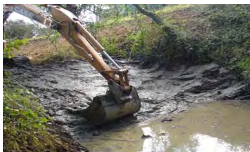
Lissage argile et adoucissement berge sud
