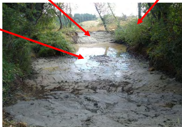
Après travaux : photo prise en sep 2010
