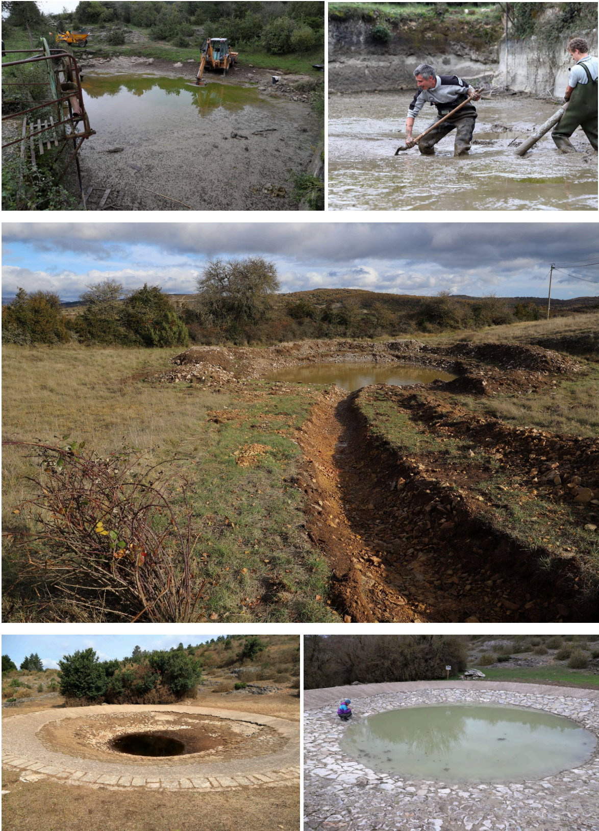
Figure 6 : Travaux de curage sur la mare Puit Laurent (Nov. 2022), canal d'arrivée et pose d'une bâche EPDM sur la mare de La Baraque Froide (Nov-2021) et restauration de la lavogne de l'Aire (Avant/après janvier 2024) - Photos: J. Bussière, PNR GC 2021-2024.
